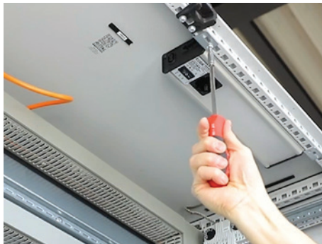
Assemblage par vis sur le coffret
