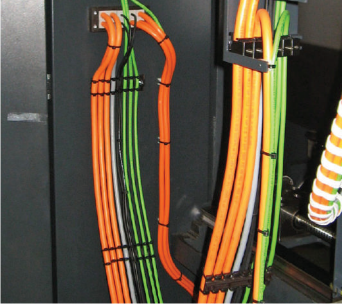
ZL 180 Makine yapımı
