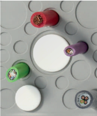
Kullanılmayan delikler ST-B tapalar ile kapatılır
