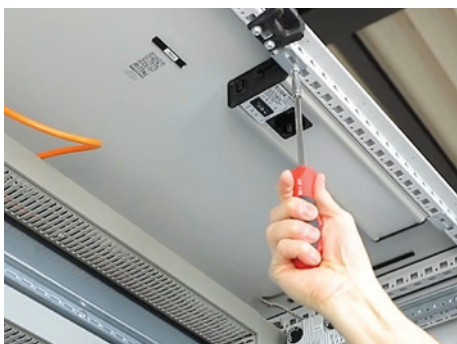
Montáž pomocí šroubů na povrchy
